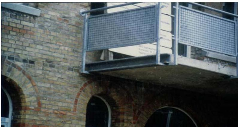
Bild 6 Anschluss Balkon
