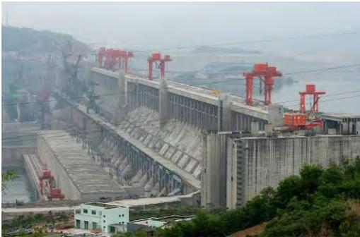
Der Drei-Schluchten-Staudamm befindet sich in der Xiling-Schlucht. Durch ihn stieg das Wasser bis 2009 um mehr als 90 m auf ein Niveau von 175 m über Meeresspiegel an. Der durch die Staumauer entstandene Stausee erstreckt sich durch alle drei Schluchten über mehr als 600 km bis nach Chongqing. Etwa 1,3 Mio. Chinesen wurden umgesiedelt.
