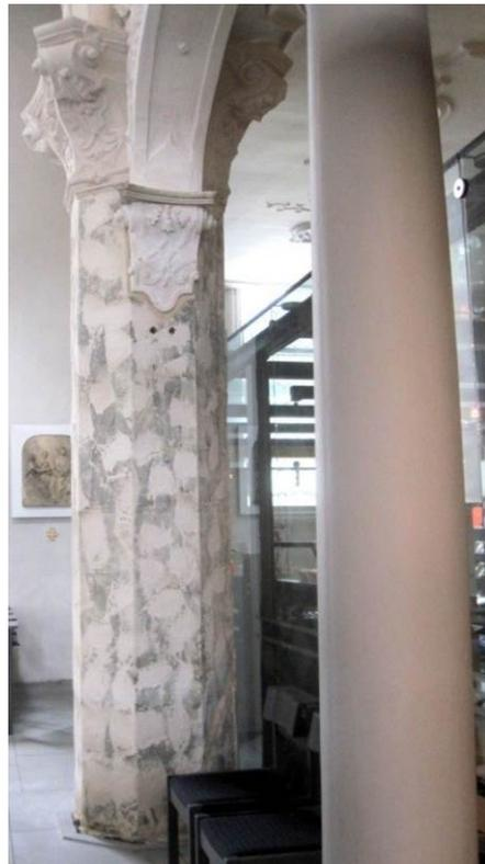
*Abbildung 4: Komplette Ansicht einer Säule mit abgenommener Komresse.*
