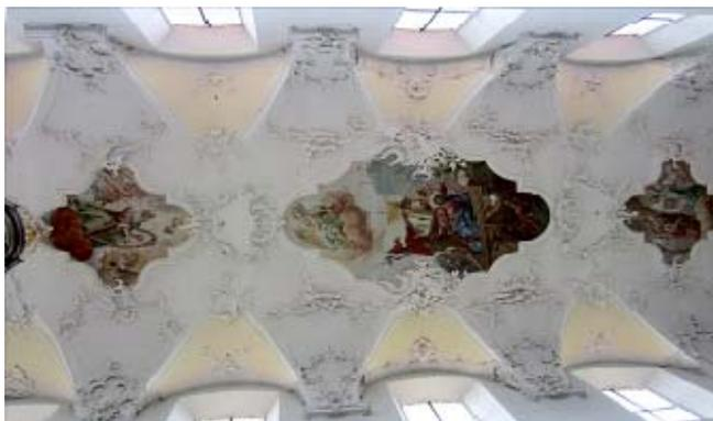
*Abbildung: Flachgewölbte Stuckdecke mit Stichkappen*
