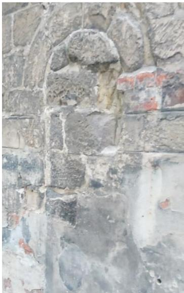
Abb. 21 zugemauerte Öffnung im Turm, zugehörig zum Vorgängerbau (Foto: A. Mock, Mai 2018).
