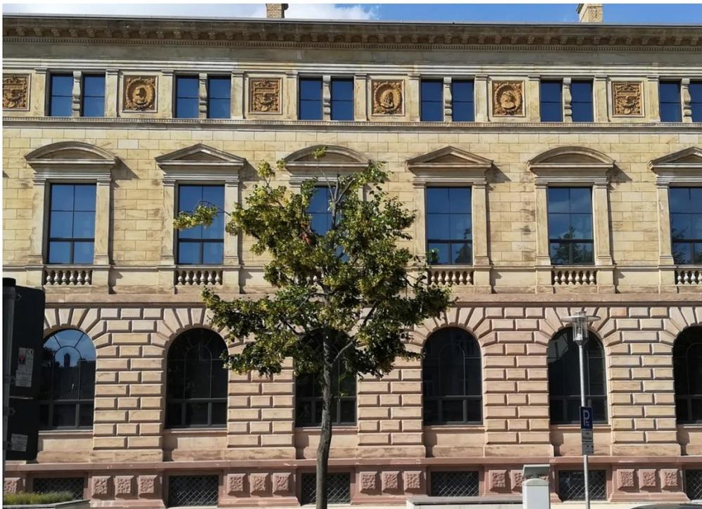
Abb. 40 Sockelzone mit rosafarbenem Stein aus Stadtoldendorf und Geschosse aus gelben Sandstein aus Lutter am Barenberge. (Foto: A. Prothmann, Mai 2018)
